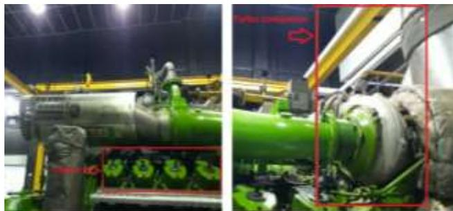
Figura 3: Turbo compresor y cilindros del motor.
