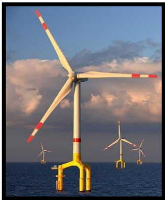
Fig. 2. Montaje de aprovechamiento de energía eólica offshore de estructura fija Fuente: Modificado de [7] [8].
