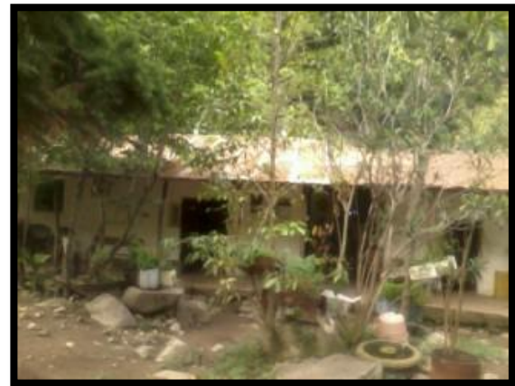
Fig. 7. Fotografía construcción rural avaluada.
